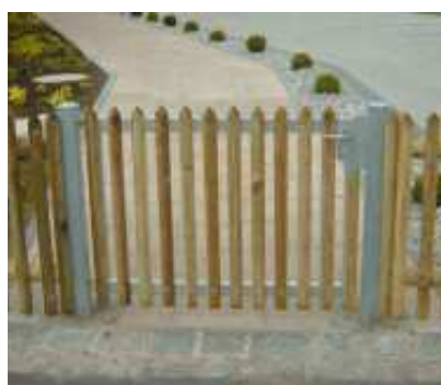
Gartentorrahmen mit Staketenfüllung
